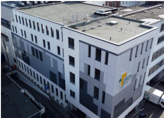
Der neue Gebäudeteil F-Flügel des Pius-Hospitals in Oldenburg ist circa 21 Meter hoch und beinhaltet diverse Funktionseinheiten auf insgesamt 3.700 Quadratmetern. Foto: Daniel Clören.
